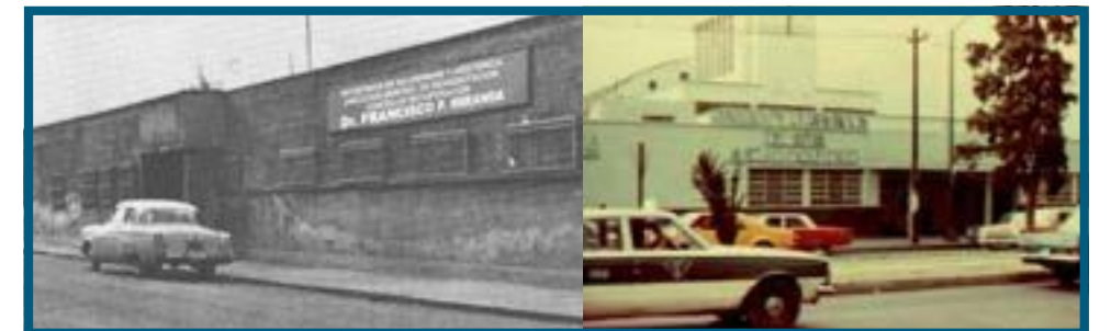
De izquierda a derecha: Centro de Recuperación Dr. Francisco de P. Miranda y Centro de Rehabilitación Núm. 5 del Sistema Musculoesquelético
