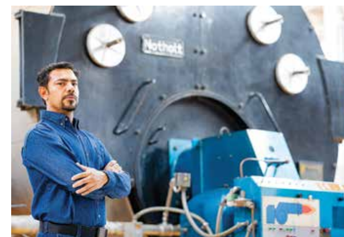
Said Hernández Rivera Conservación y mantenimiento (casa de máquinas)
